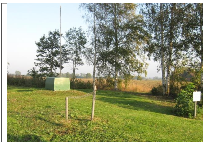
Boringen på Mårvej 15 er i 2011 løftet op i hus, for herved at sikre mod nedsivning fra lavtliggende områder rundt om boringen.
